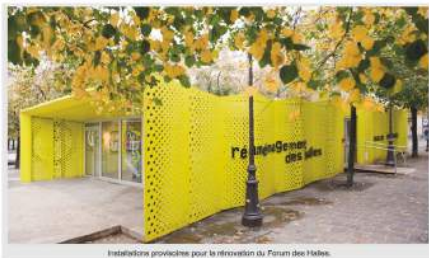
Installations provisoires pour la rénovation du Forum des Halles.
