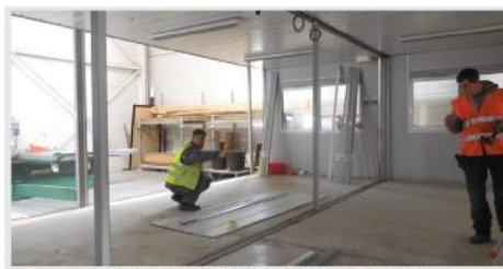
Construction d'une installation provisoire dans les ateliers de Bennwihr-gare, près de Colmar.
