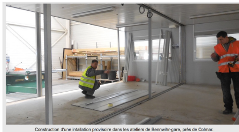
Construction d'une installation provisoire dans les ateliers de Benwihr-gare, près de Colmar.
