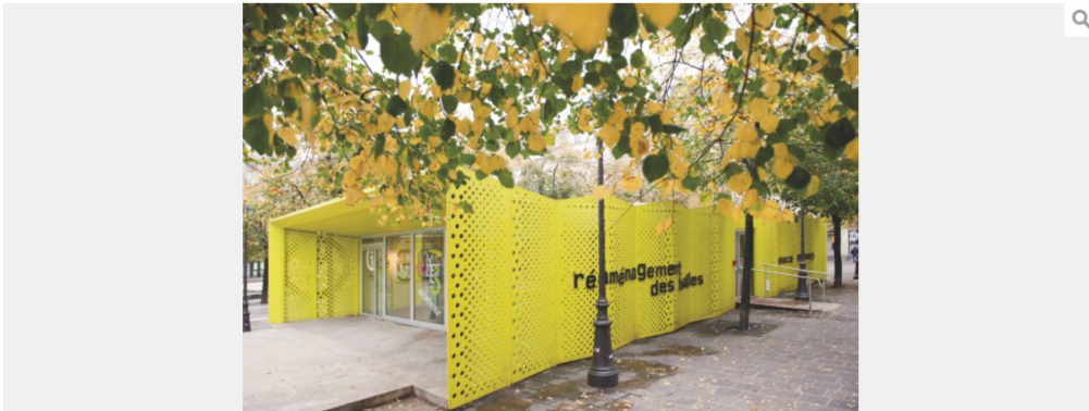
© Altempo - Les constructions modulaires pour la rénovation du Forum des Halles, toujours en cours, ont boosté l'activité nationale d'Altempo.
