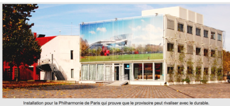
Installation pour la Philharmonie de Paris qui prouve que le provisoire peut rivaliser avec le durable.
